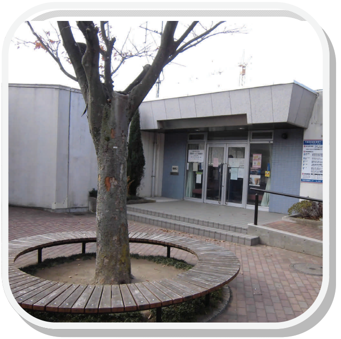
管理サービス事務所 Management Service Office
