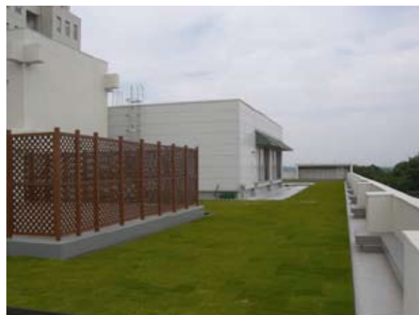
プレイルームを囲むように植栽された高麗芝。手前はウッドデッキ
