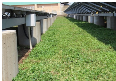
ダイカンドラを育成するソーラーシェ アリングの事例 (出典) 加藤伸一「東金市のメガソーラー に見る、多年草「ダイカンドラ」による 雑草対策」『日経XTech』2017年6月13 日
