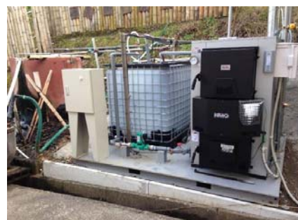
▲温泉施設用の丸太加温器と熱交換器
