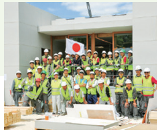
日本からも多くの応援が 駆けつけた建設工事
