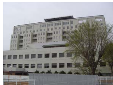
医学部附属病院新病棟(ひがし棟)
