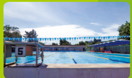
老朽化が激しく夏しか使えない屋外プール
