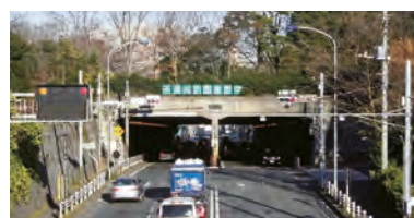
② 松戸トンネル(国道6号線)
