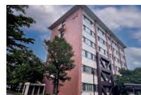
④ 理学部5号棟（高層）
