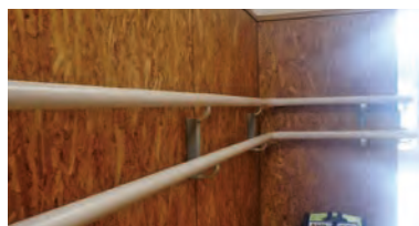
廊下の手すり
