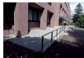
スロープ + 点状ブロック
