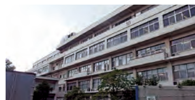
② 工学部 10 号棟
