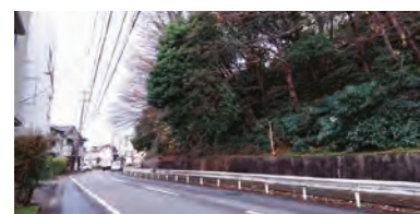
④ 歩道整備 (本町 22 号線)
