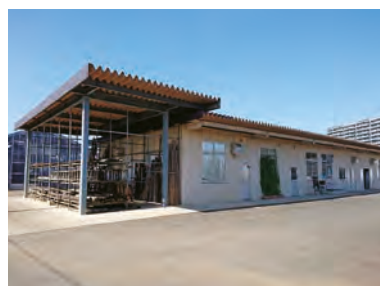
作業実習棟(低層)
