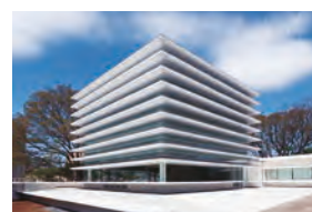
③ いのはな同窓会館 (低層)
