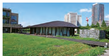
シーズホール（南側）
