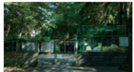
④医学部本館北側
