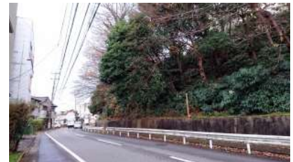
④歩道整備（本町 22 号線）
