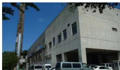
①医学部附属病院エネルギーセンター
