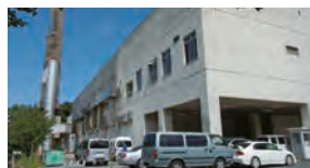
医学部附属病院エネルギーセンター
