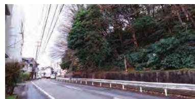
④ 歩道整備 (本町 22 号線)
