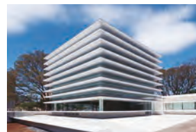
③ いのはな同窓会館 (低層)
