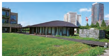
シーズホール (南側)
