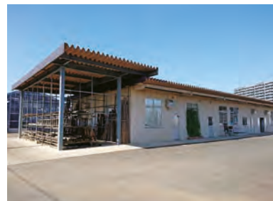
作業実習棟(低層)
