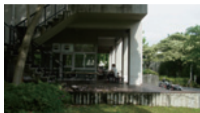
⑤E棟ピロティ
