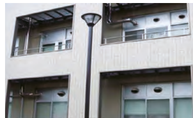
① C棟周辺
