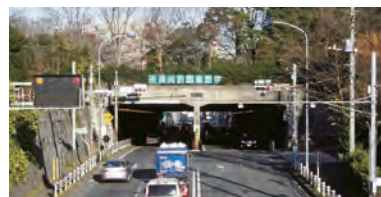
② 松戸トンネル(国道6号線)
