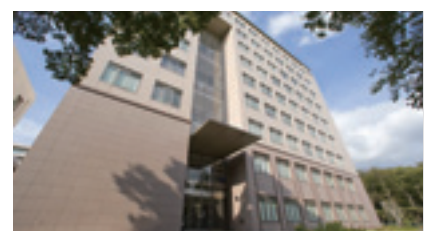
④自然科学系総合研究棟（高層）
