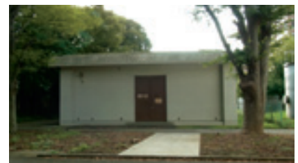
②受配電室
