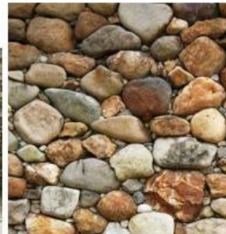
自然石の特徴を生かした石積
