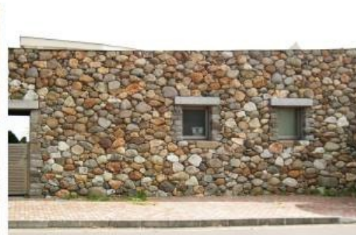
高さ7m自然川石を使用した野面積み壁面
