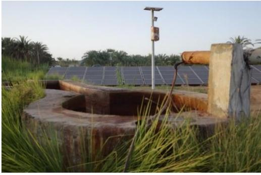
写真1 現地の灌漑用の井戸：ポンプを使った揚水のための電力は、ソーラー発電で賄っている。
