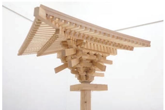
図5：部材の反り、転びを忠実に再現した美しい木組みを見せる屋根隅部
